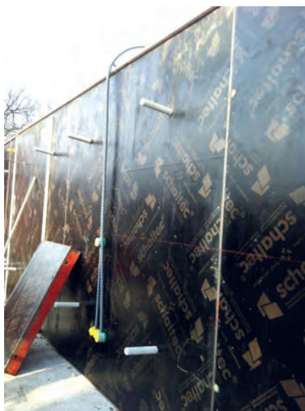
Bild 1: Unbewehrte Betonwand vor dem Zuschalen und nach dem Ausschalen
