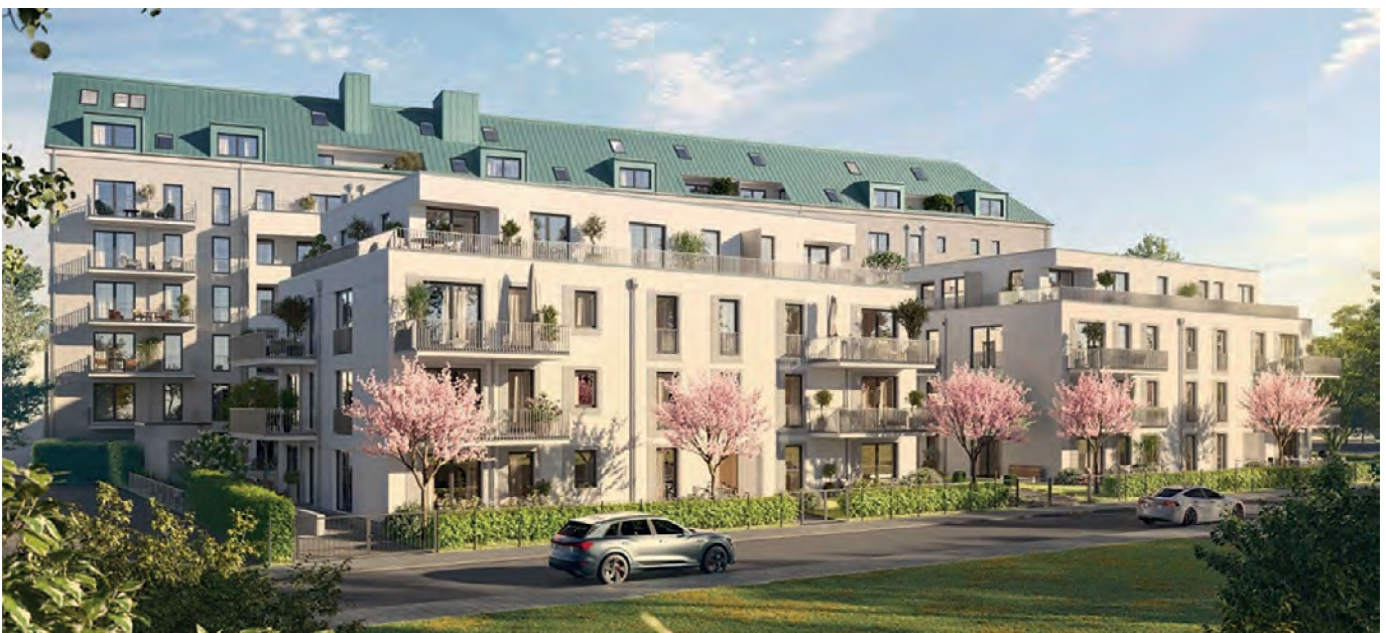
Bild 6: Neubau einer Wohnanlage mit 130 Wohneinheiten in München an der Landsbergerstrasse
